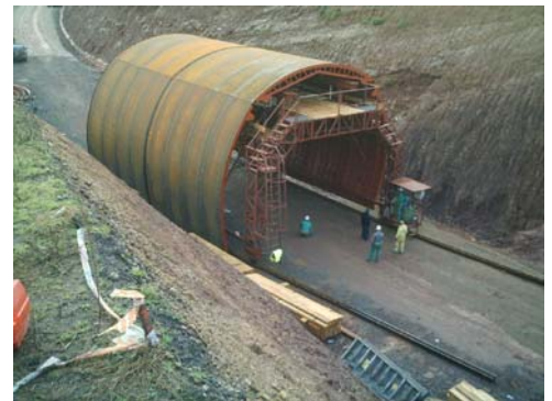
Dirección de Obra Nueva carretera Luanco – Candás. Carro Encofrador
