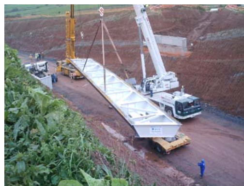
Dirección de Obra Nueva carretera Luanco – Candás. Montaje Viga
