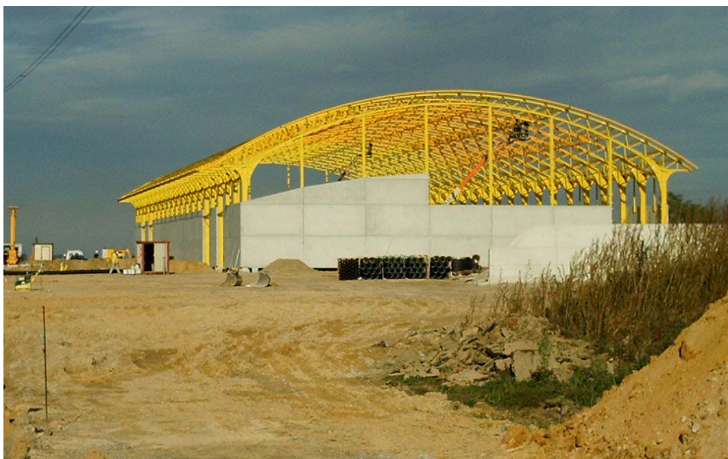
Dirección de Obra nuevas naves de papel y cartón vertedero de COGERSA en Serín (Asturias)
