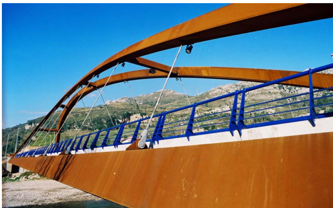
Puente sobre Carretera AS-114. Tramo: Niserias - Panes (Asturias)
