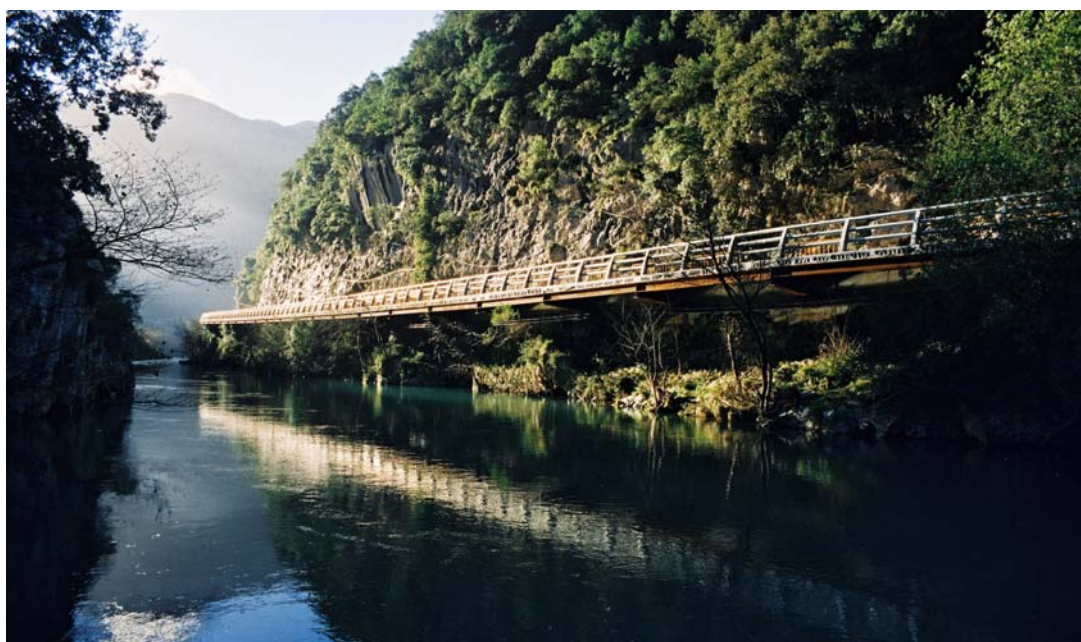
Proyecto Carretera AS-114. Tramo: Niserias - Panes (Asturias)
